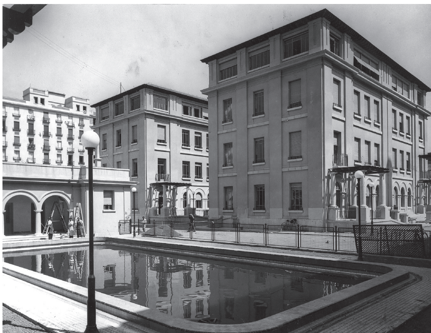
Fotografía 6. Exterior Grupo Escolar. J. Sorolla de Madrid, 1933. Fuente: Ministerio de Cultura y Deporte. Archivo General de la Administración. Sección de Obras Públicas. Fondo 82. Sobre 22.
