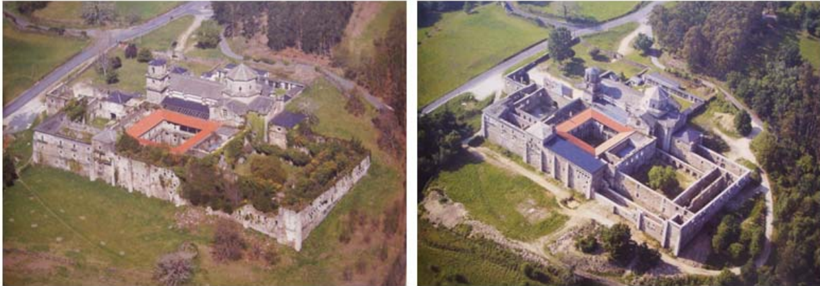
Figura 8. Antes (abril 2008) y después (abril 2011) de la 1ª fase de intervención.
