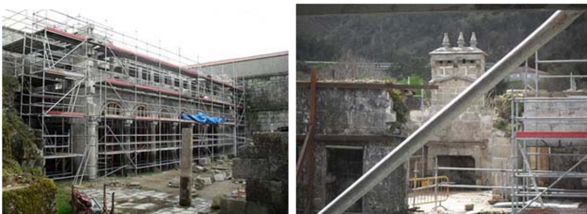
Figura 5. Vistas de las obras de la primera fase de intervención (agosto 2010)
