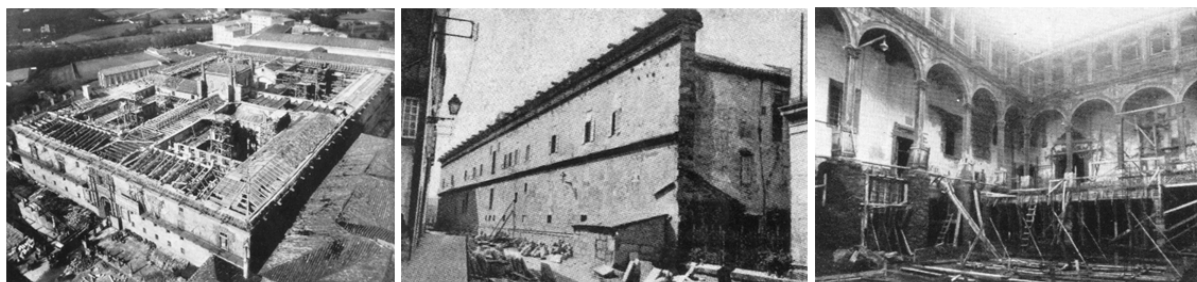
Figura 2. Vistas de las obras de vaciado y reconstrucción en 1954.
