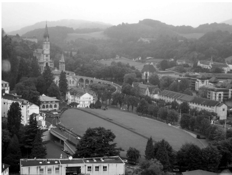
Foto 1. Vista de las edificaciones en Los Santuarios. Bajo el césped en forma de barca y de pez se encuentra la Basílica subterránea San Pío X y al fondo la montaña del Valle Pirenaico.
