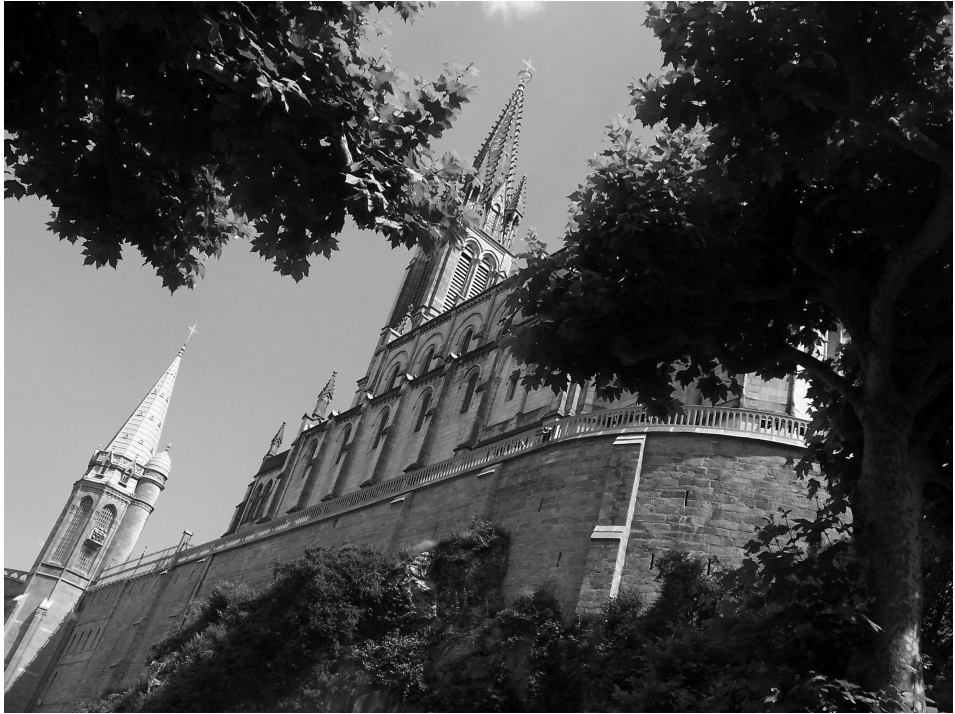
Foto 7. Vista de las primeras edificaciones sobre la Gruta.
