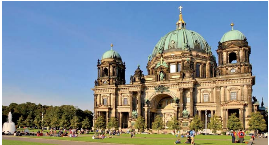
Fig. 06. Catedral Evangélica de Berlín (Alemania). Primera capilla, 1465; nuevo edificio barroco, Johann Boumann el Viejo, 1747/50; remodelación, Karl Friedrich Schinkel, 1822; edificio actual, Julius Carl Raschdorff, 1893/1905; reconstrucción post-guerra, 1975/93.
