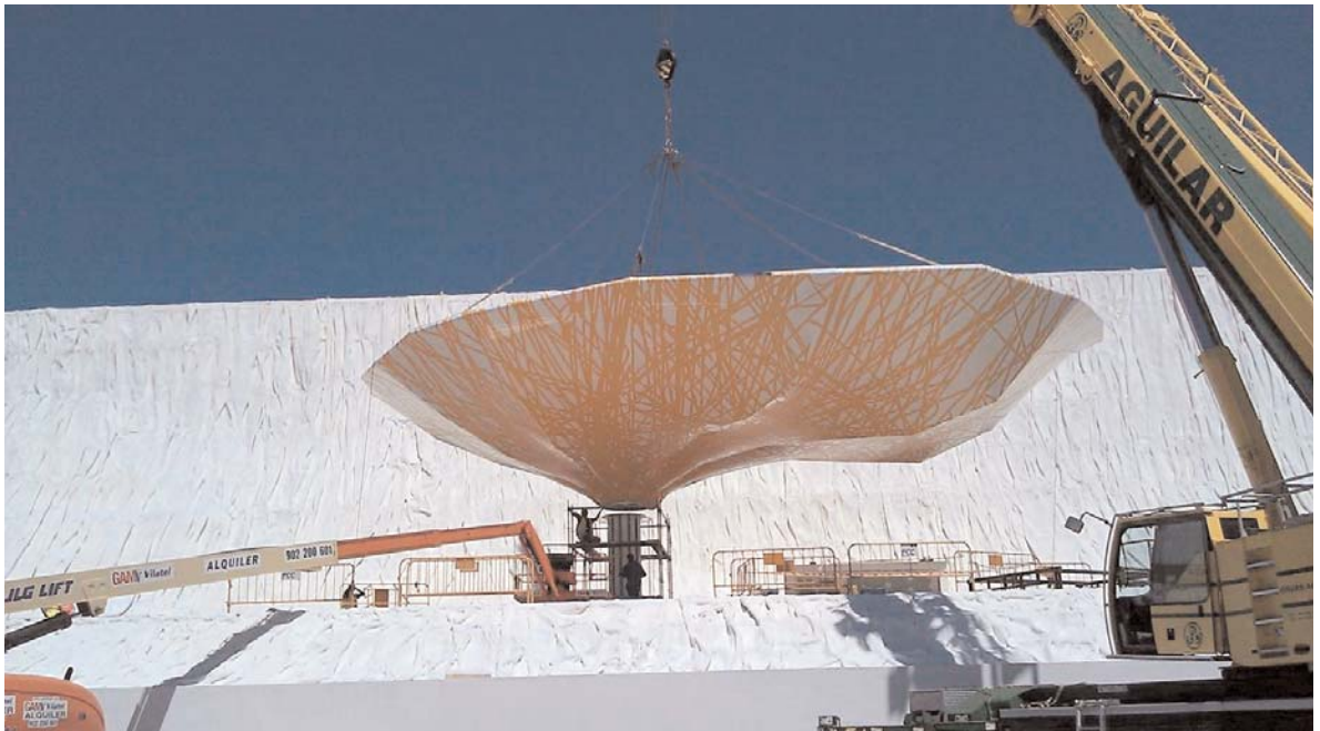
Fig. 19. Izado y colocación de la estructura arborescente retroiluminada.
