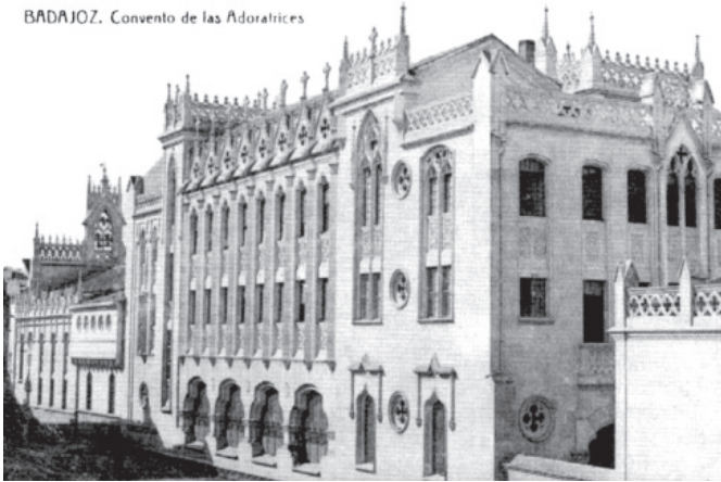
Fig. 1. Curro Franco Pineda, convento de las Adoratrices, 1915/19. Fachada hacia la calle Suárez de Figueroa.
