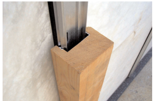
Fig. 22. Detalle de los montantes del muro de alabastro.
