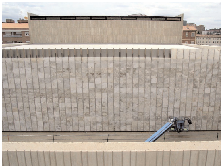
Fig. 21. Montaje del muro de alabastro (2007).
