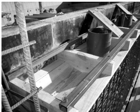
Fig. 18. Detalle de la coronación de los muros de hormigón armado.
