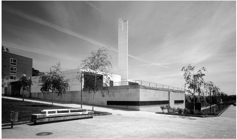
Fig. 7. Estado de la iglesia al término de la primera fase de las obras.
