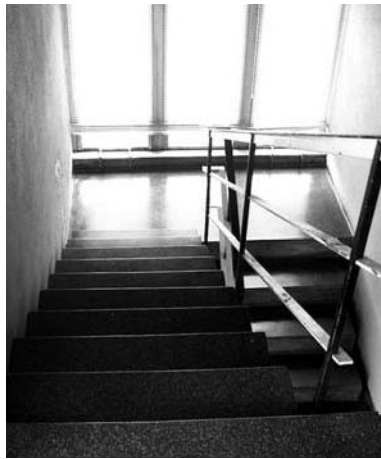
Escaleras de acceso a las dependencias superiores.
