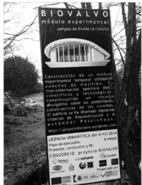
Fotografía 1: Edificio experimental construído con cunchas de mexillón e técnicas de bioconstrución
