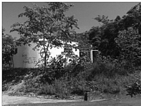
Figura 5: Banheiro. (Trancado e Esteticamente Depredado). Fonte: SERRA 2015
