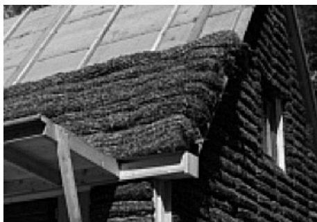
Figura 8: Construção na Dinamarca com alga no telhado e paredes para isolamento térmico (RESENDE, 2013).
