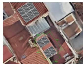
a) Instalación VilasSOL#0
