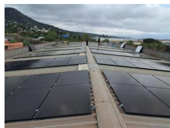
b) Instalación VilasSOL#1
