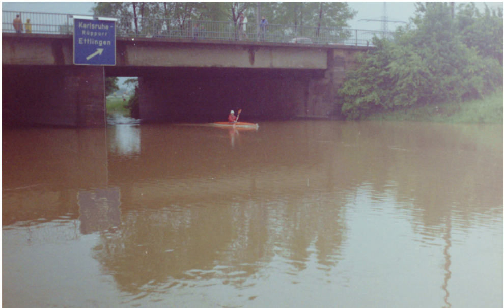
Figura 22. Espectacular crecida del riachuelo Alb en el mes de mayo de 1978 cuando se inundó la autopista federal A5 en la sección de la salida de Karlsruhe-Ettlingen (SO de Alemania).
