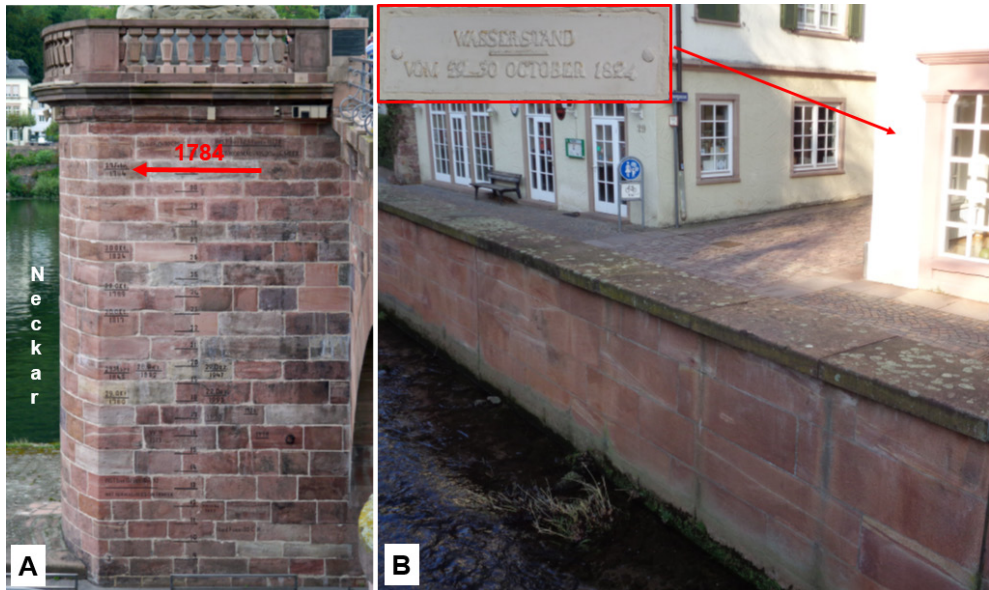
Figura 19-A. Marca de las avenidas del río Neckar de 1784 en el Viejo Puente de Heidelberg (Alemania); 19-B: Marca de las avenidas del río Alb de 1824, orilla derecha, cerca de la torre del ayuntamiento de Ettlingen (suroeste de Alemania).
