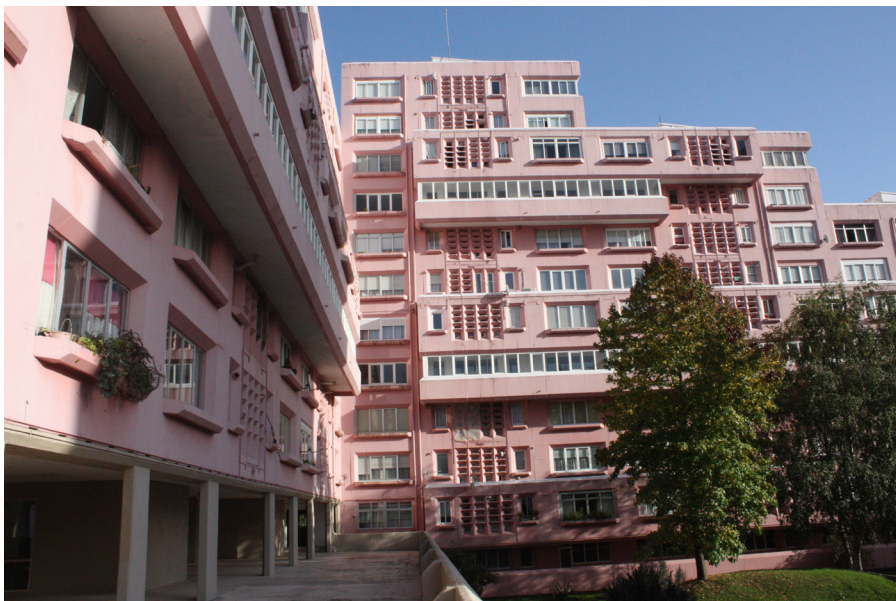
10. Vista de la esquina interior del bloque L10, con los diferentes tipos de paneles usados.
