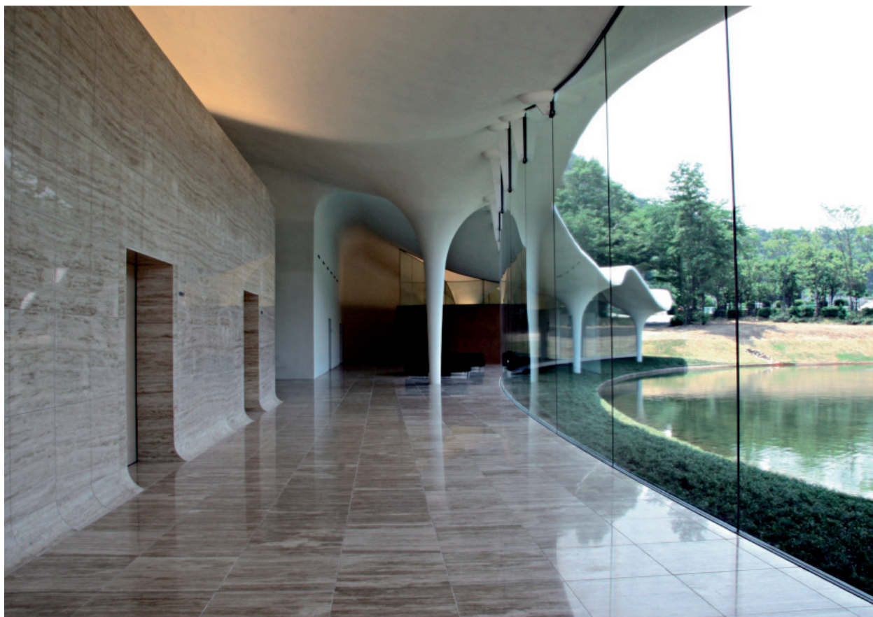
7-8 Toyo Ito, crematorio Kakamigahara, Gifu, Japón, 2004-2006. Vista del exterior y vista del interior
