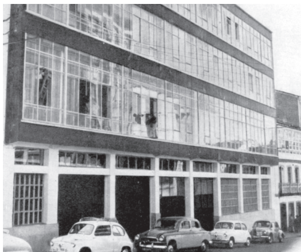
7 Casa Sindical, Lugo; fachada posterior.
