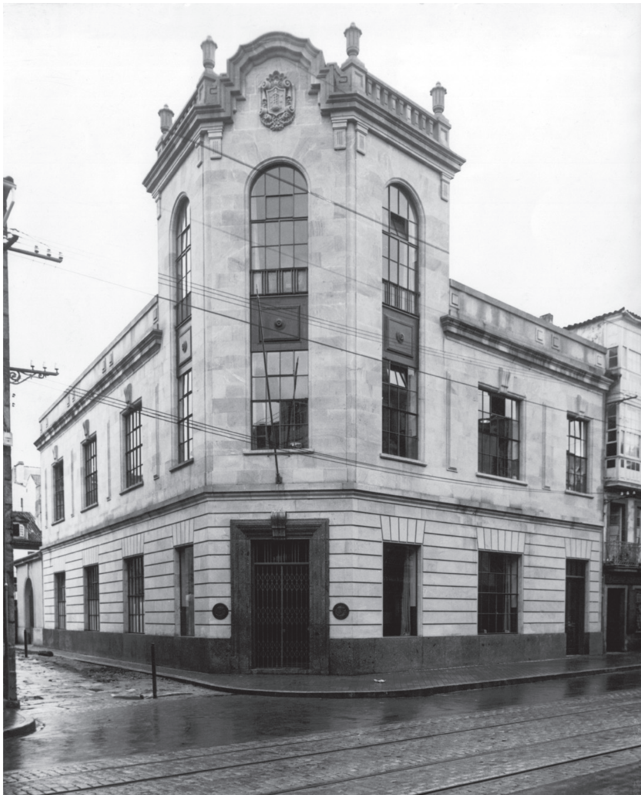
10 Central telefónica de A Coruña en la calle de San Andrés (1928/30).
